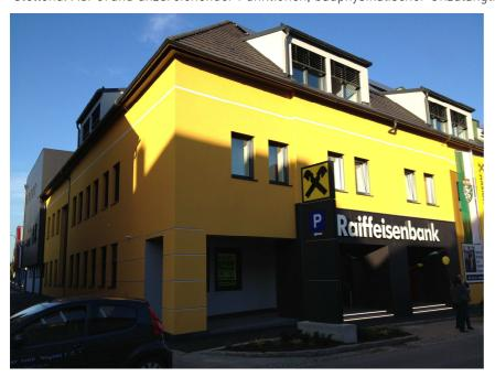
Bankgebäude thermisch zu sanieren und auch zu erweitern. Das Gebäude hatte einen Heizwärmebedarf lt. Energieausweis von 194 kWh/m²a, damit verbunden waren hohe Folgekosten bei der Konditionierung.
